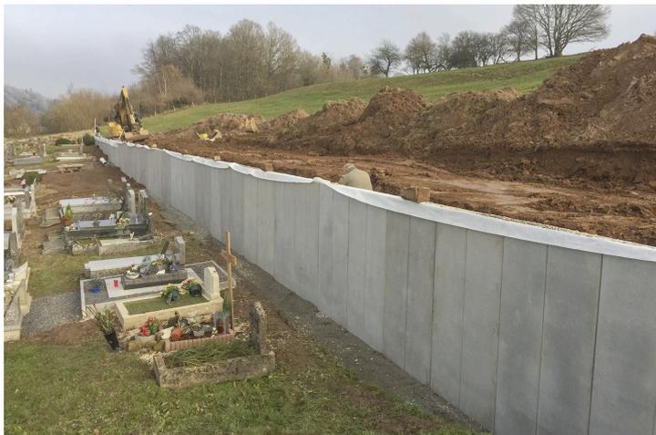
L'entreprise Rauscher a enlevé les restes du mur du haut et a déjà remis en place un nouveau mur en béton en L préfabriqués. Un drainage a été posé à l'arrière du mur ainsi qu'un caniveau qui permettra d'évacuer les eaux pluviales en temps normal. En cas de pluies exceptionnelles si le caniveau ne suffit pas, le surplus d'eaux sera dirigé vers le côté droit du cimetière qui sera enroché pour éviter le ravinement.
